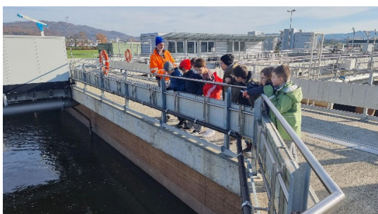
Urs Emmenegger erläutert das SBR-Verfahren (Sequentielle Biologische Reinigung)
