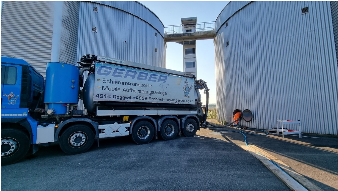
Abpumpen des Restschlammes im Faulturm
