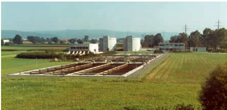
So präsentierte sich die Kläranlage nach Beendigung der Umgebungsgestaltung (1976).
