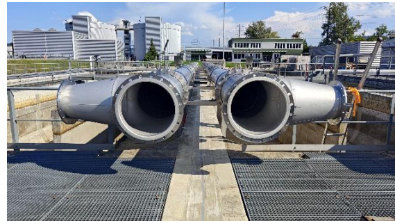
August 2023: Montage der Beschickungsrohre über den bestehenden Becken
