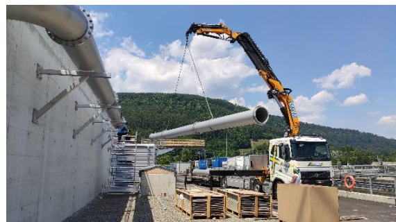
Juni 2023: Montage der Beschickungsrohre an den Beckenwänden
