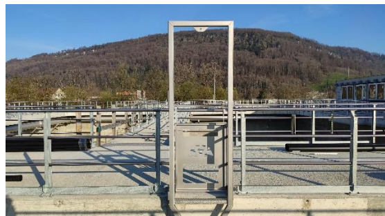
April 2023: Geländerbau auf den Becken
