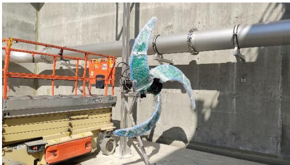
August 2023: Montage der Rührwerke in den neuen Becken
