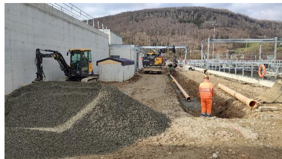
Februar 2023: Leitungsarbeiten für die Platzentwässerung
