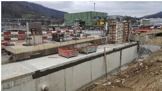
Januar 2023: Bau einer Verbindung zum Bestehenden Werkleitungsgang
