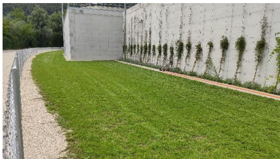
August 2023: Beckenbegrünung und Rasen spriessen bereits
