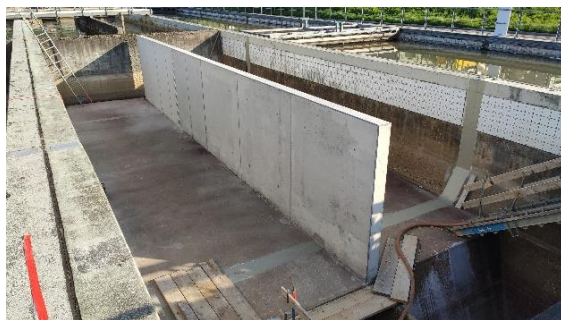
Mai 2023: Trennwände für die künftigen Vorlage Becken
