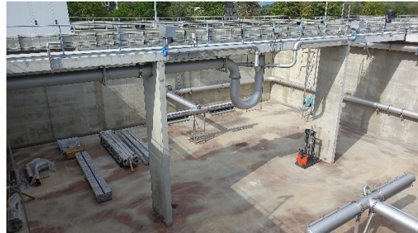
Juli 2023: Montage der Rohrleitungen in den neuen Becken
