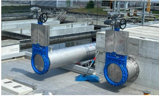
Juni 2023: Die ersten Schieber sind montiert
