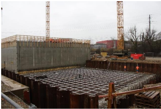
Januar 2022: Armierung und Spannkabel für die dritte Bodenplatte
