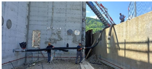
Mai 2022: ARA-Personal montiert Schläuche für das Befüllen der Becken (Dichtigkeitsprüfung)
