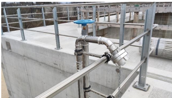
September 2022: Geländer- und Sanitärarbeiten auf den Becken
