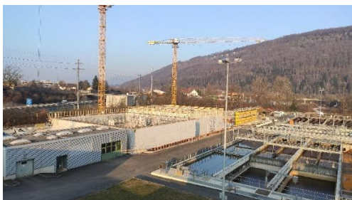
März 2022: Becken 1 und 2 erstellt, im Bau Wände für das dritte Becken
