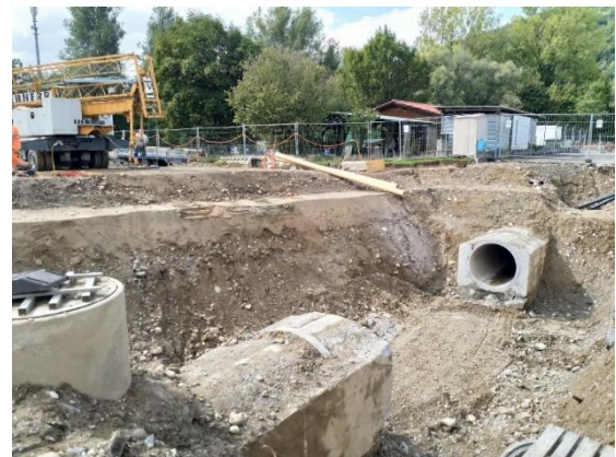
September 2022: Aushubarbeiten für das Vereinigungsbauwerk
