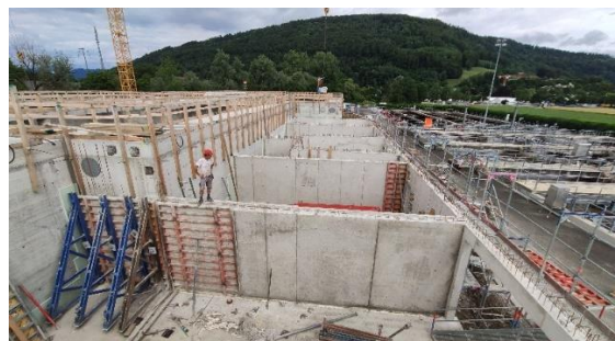
Juni 2022: Die Betriebsräume zwischen den Becken nehmen Gestalt an
