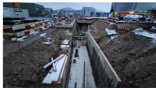
Dezember 2022: Baubeginn Ergänzung Werkleitungsgang
