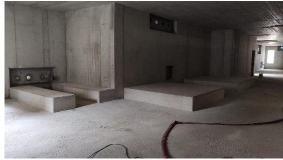
August 2022: Sockel für die Pumpen im UG der Betriebsräume
