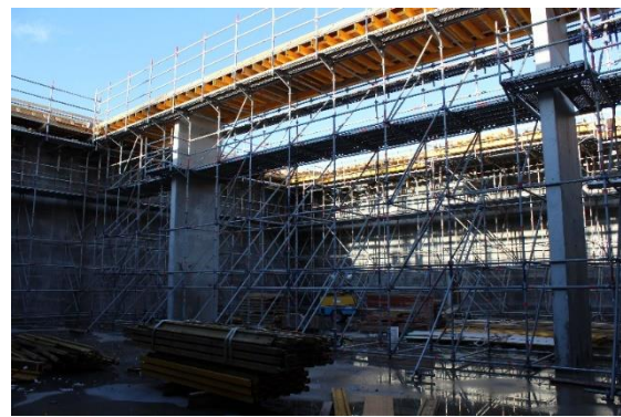
Februar 2022: Gerüst und Schalung für den Steg über das Becken
