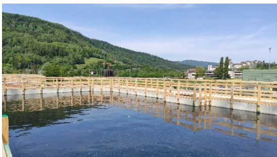
Mai 2022: Gefülltes Becken für die Dichtigkeitsprüfung
