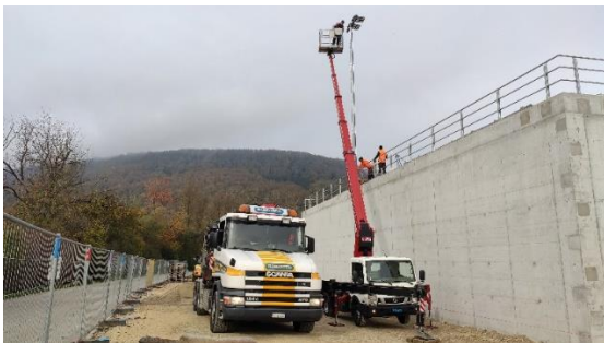
November 2022: Beleuchtungsmasten werden montiert
