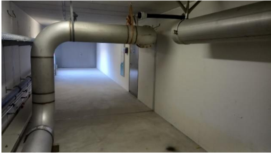
Juni 2022: Die Belüftungsrohre werden provisorisch verlegt
