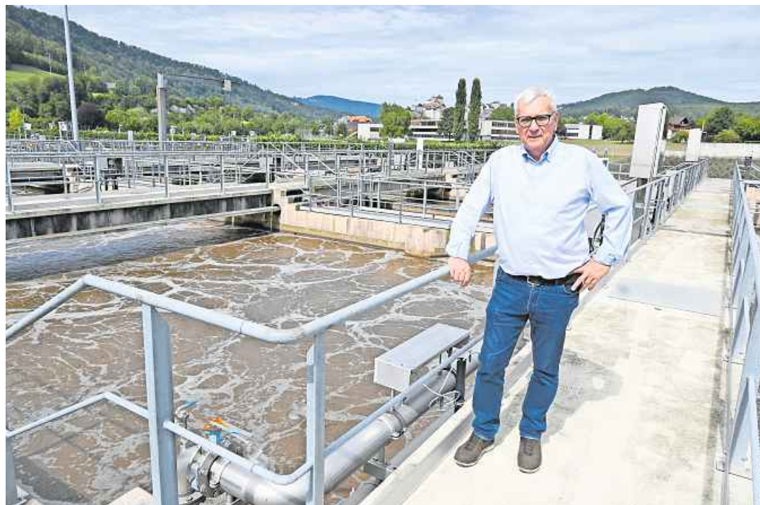
Erich Schnyder ist seit 30 Jahren Betriebsleiter des Abwasserverbandes Aarburg. Die Erweiterung der Biologie wird das letzte Bauprojekt sein, das der langjährige Geschäftsführer leiten wird. Bild: Thomas Fürst
