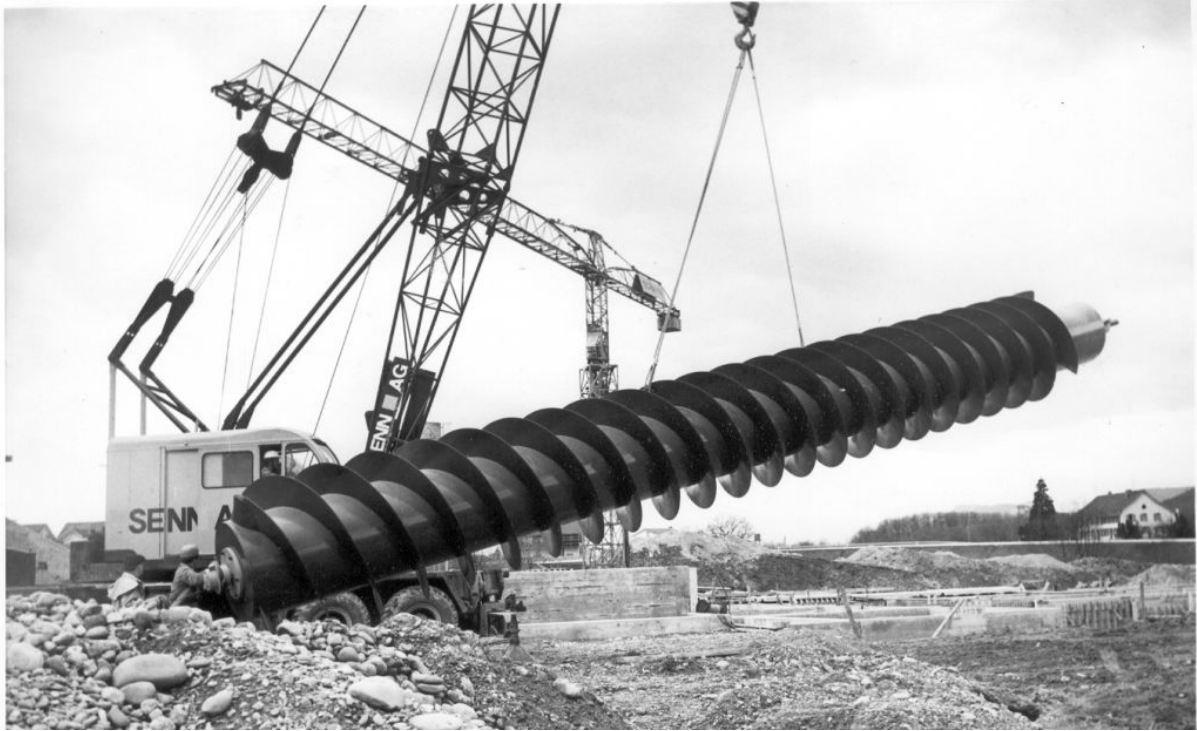
Einbau der mächtigen Förderschnecken im Abwasserhebewerk mit einem Senn-Kran
