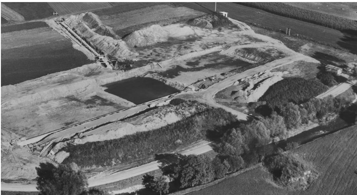
Eingestellte Aushubarbeiten im Spätsommer 1968 wegen zu hohem Grundwasserstand
