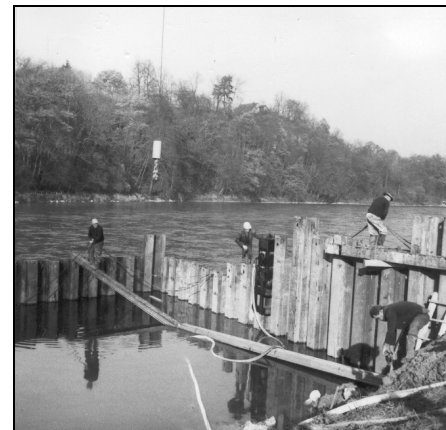
Bau Auslauf in die Aare
