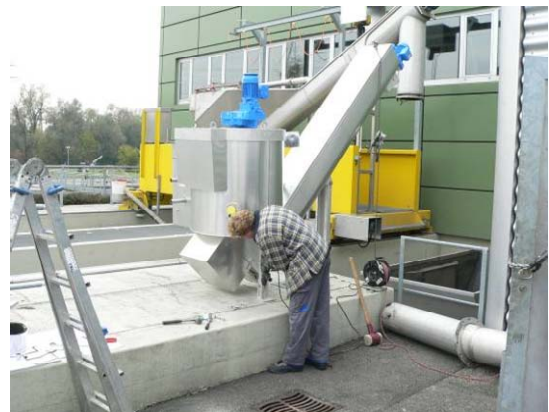
Montage des Sandwäschers
