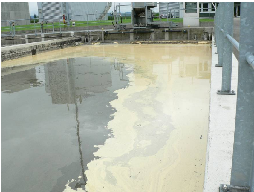
Ölteppich im Vorklärbecken
