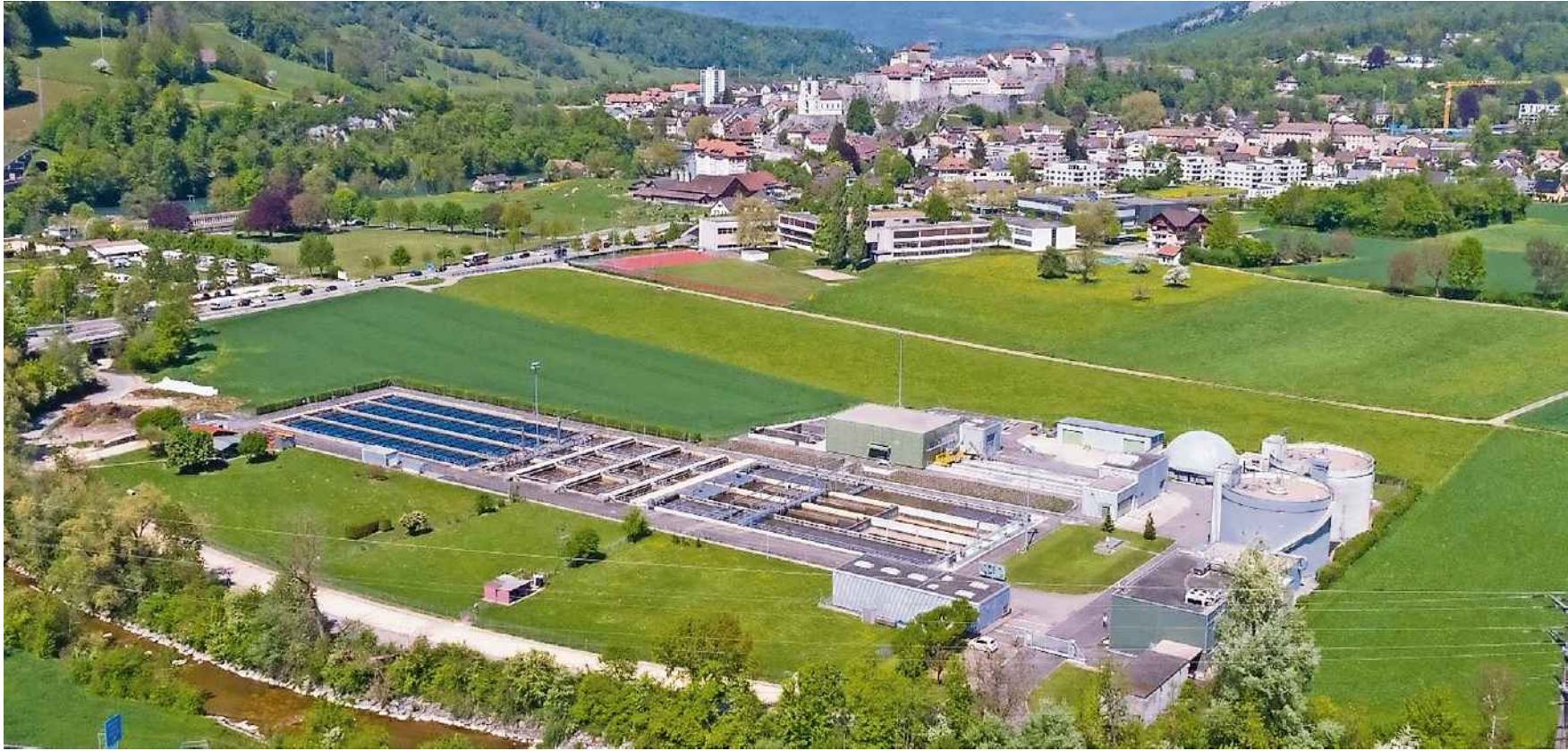
Die Kläranlage Aarburg erfährt in den nächsten Jahren verschiedene Sanierungen.
